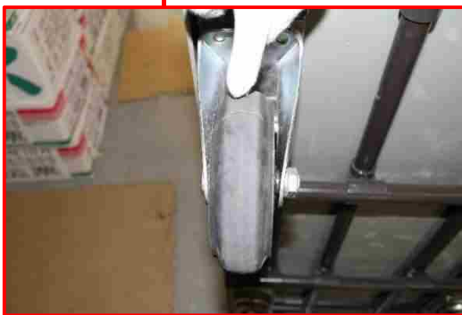
写真19 台車右前輪の圧痕 (昇降路内梁エッジ部への食い込み)
