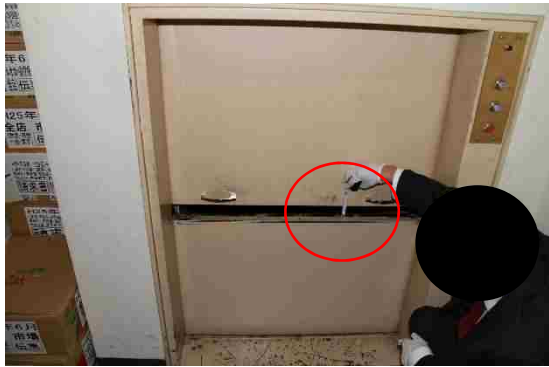
写真7 施錠時の出し入れ口隙間確認
