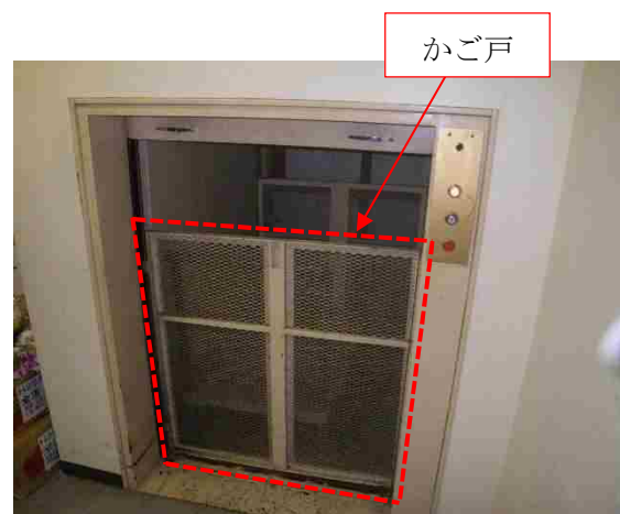
写真2 出し入れ口の戸が開いた状態
