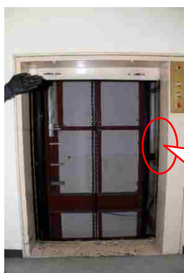
写真5 ドアスイッチ取り付け位置
