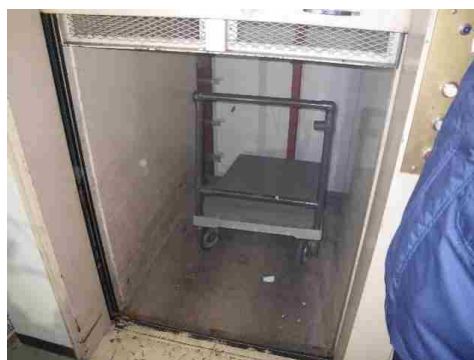
写真7 かご内に台車をいれた状態（奥側へ飛び出した状態）
