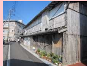
空き家の除却
