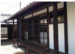
古民家を宿泊施設に改装して運営(明日香村おもてなしファンド)
