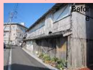
空き家の除却
