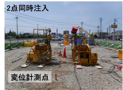
図 4.4 2 点同時注入時の施工状況
