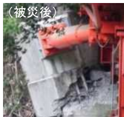
制震ダンパー取付部の損傷
