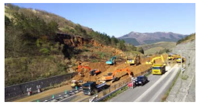
復旧作業状況
