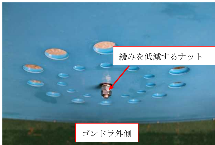
写真10 対策品施工
