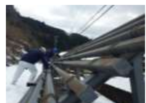
雪崩危険箇所点検（石川県）
