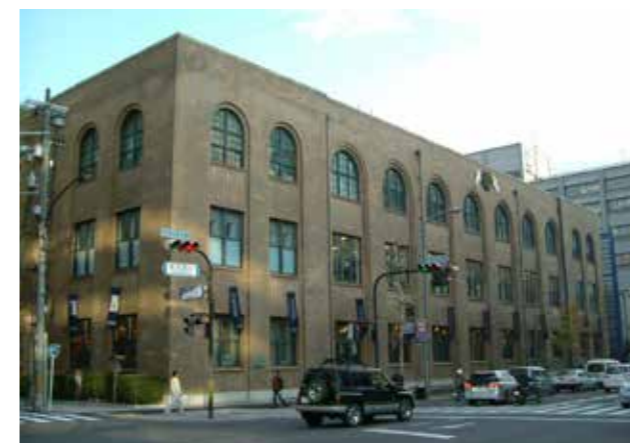
写真12 京都市、新風館。1926年竣工、吉田鉄郎設計の電話交換局を2001年、商業施設に用途転用して活用されていたが、現在、旧庁舎部分の躯体を残して解体し、ホテル、商業施設などからなる複合施設に改修する工事が行われている。
