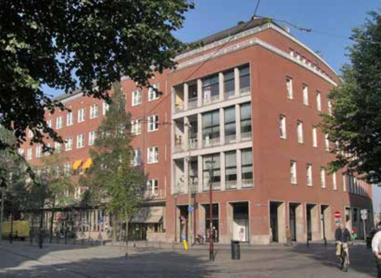
写真4 オランダ、旧ハーグ郵便局を共同住宅に改修 外観 (写真:デルフト工科大学提供)
