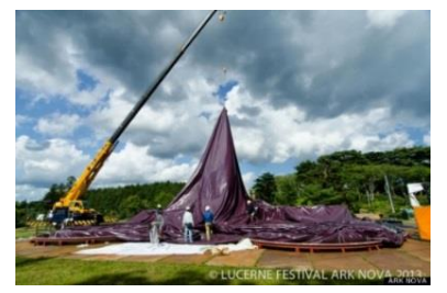
設置中の様子
