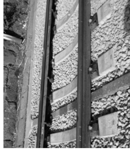
線路設備 (軌道改良(PCまくら木化))
