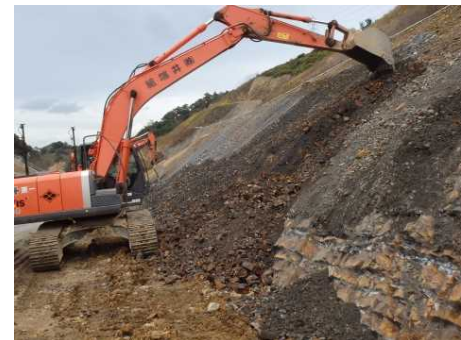
長大法面・流れ盤での掘削
