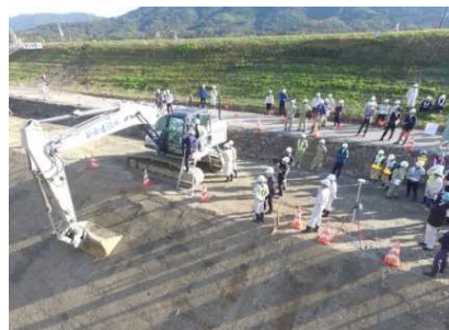
3DMGバックホーによる法面整形
