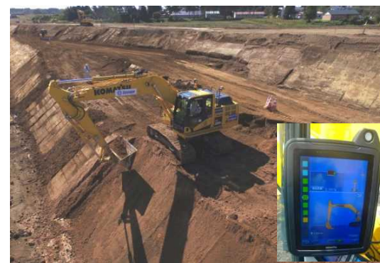
↓ MCバックホウによる盛土法面整形
