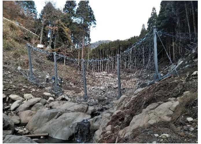
砂防堰堤を施工するために必要な応急対策として ワイヤーネットを設置
