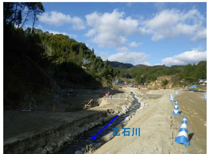
遊砂地を施工するために必要な仮排水路を設置
