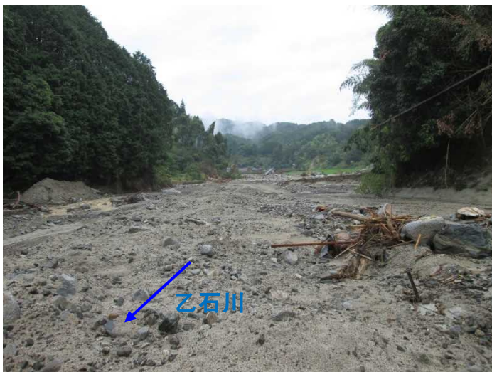
大量の土砂が河道を完全に埋塞
