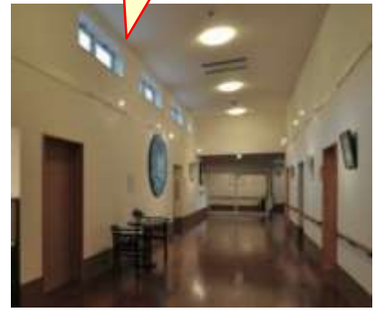
木材が見えなくなる防火被覆が設けられている
