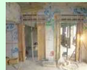
内壁等の補強
