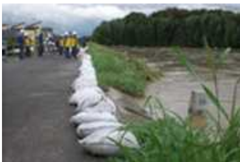
水防工法（積み土のう工）
