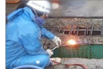
鋼材現場ガス切断状況
