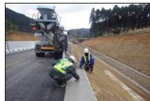
防草Co打設状況
