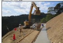
小段排水溝打設状況
