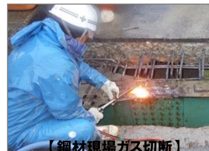
【鋼材現場ガス切断】
