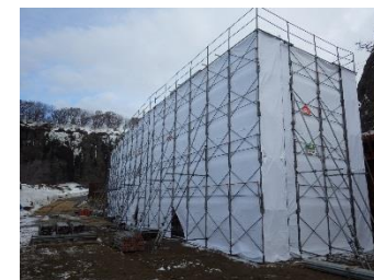
【雪寒仮囲い完成】
