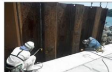
ガス切断状況
