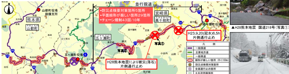
図3 国道218号の現道状況と被災状況
