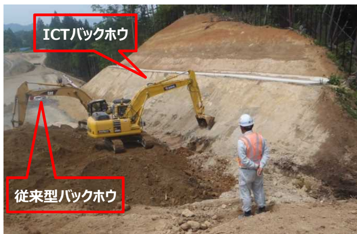
ICTと従来型の建機による施工
