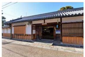
修景した町家で営まれる医院
