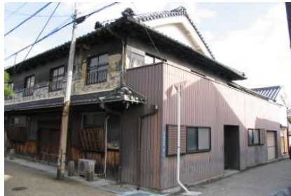
【伝統的建造物の復元修理】
