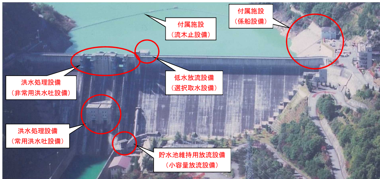
図 1.2-1 ダム用ゲート設備等(事例)
