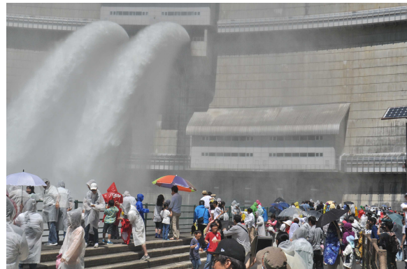
温井ダム（広島県） 水位低下放流の様子（昨年度）
