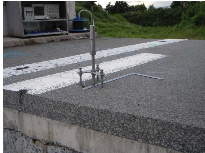
舗装を剥がさずに橋梁の床版の 劣化状況を調査した例 (床版の剥離箇所調査)
