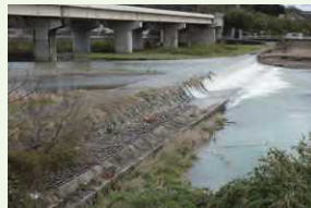
曾江谷川床固工
