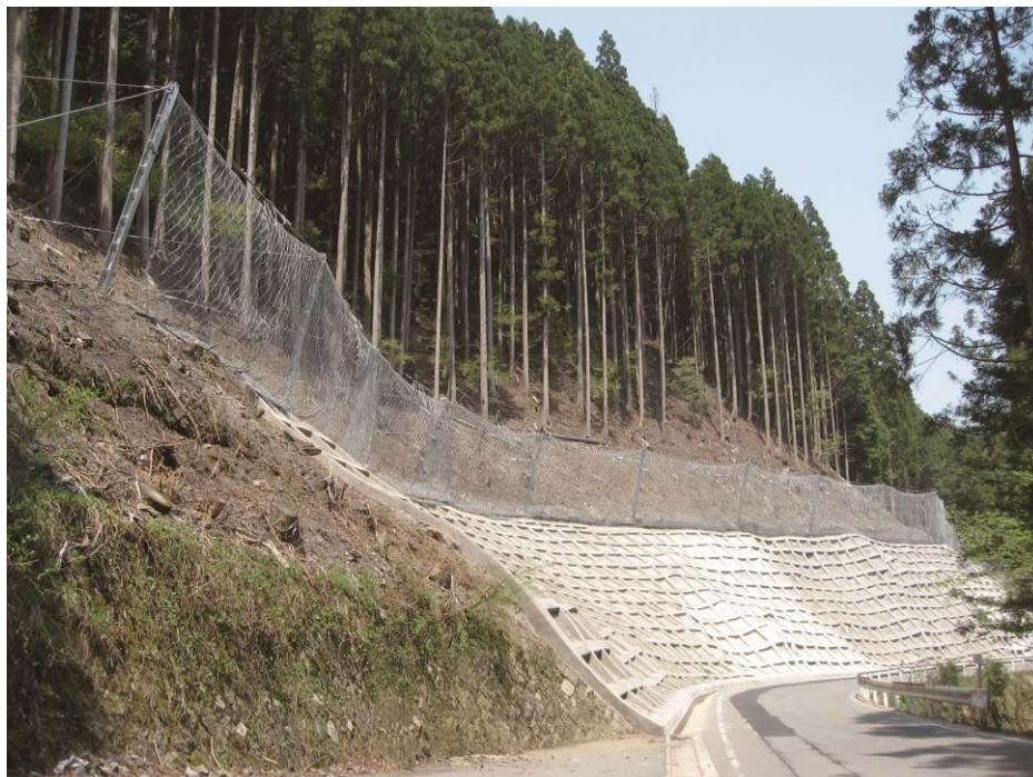
写真一 設置状況
