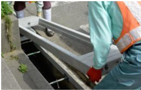
写真一 1 一次蓋設置状況
