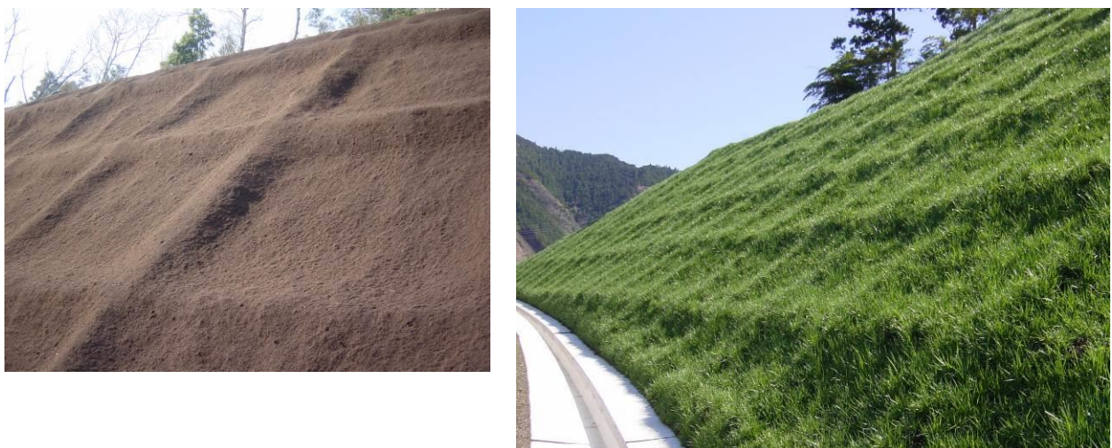
写真-3 全面緑化で景観保全が可能 (左: 施工完了、右: 施工後)
