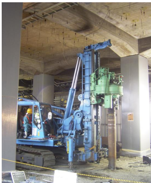
写真一 2 高架下における施工例
