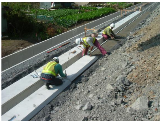
写真—3 敷設状況
