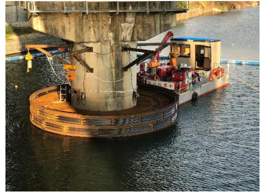
写真—2 円形組立状況
