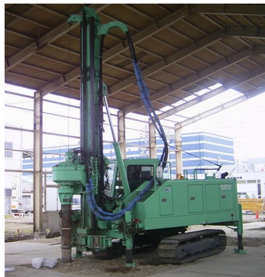
写真一 1 小型杭打機による施工状況
