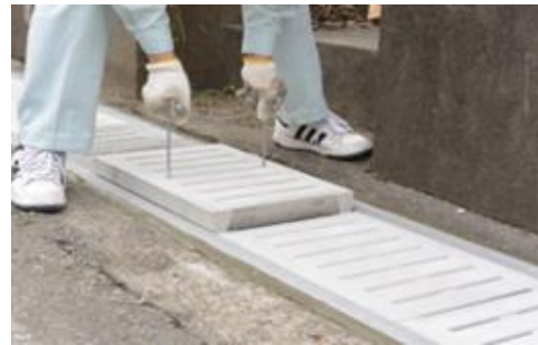
写真一 2 二次蓋設置状況
