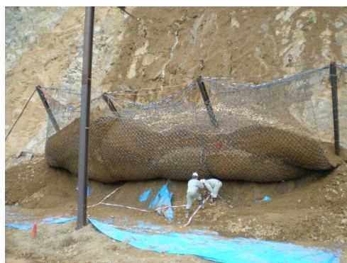
写真四 実物大性能確認試験（土砂捕捉）
