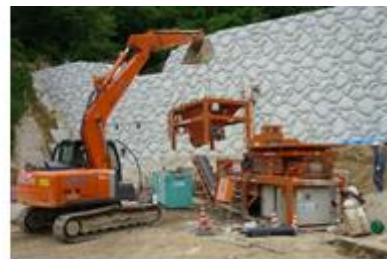
索道利用現場での組立状況
