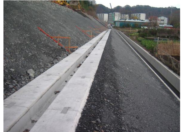
写真—4 敷設完了
