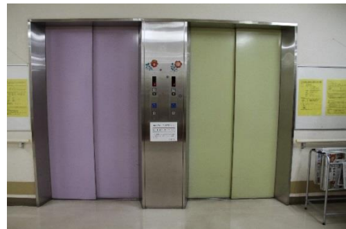
写真1 1階乗場（左側が事故機）
