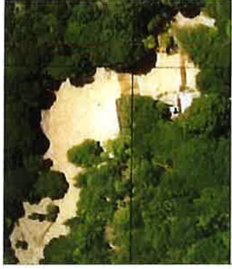
はるかぜ号撮影【水分堰堤】
