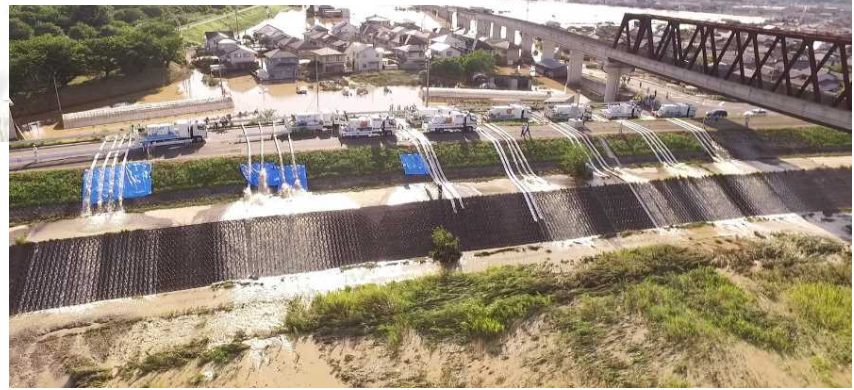
ポンプ車による排水作業状況
