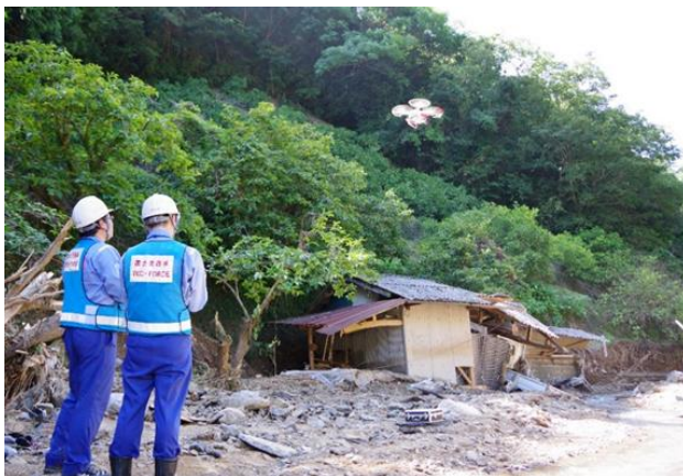
ドローンによる調査（九州地方整備局）
