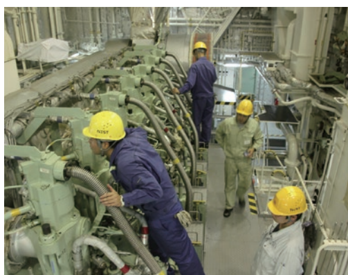
機関室当直の様子
