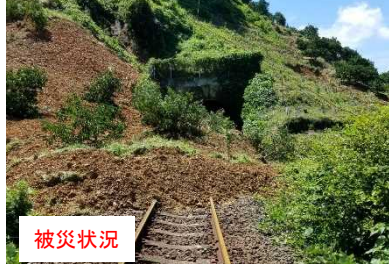
②下宇和・立間間283k990m 斜面崩壊
