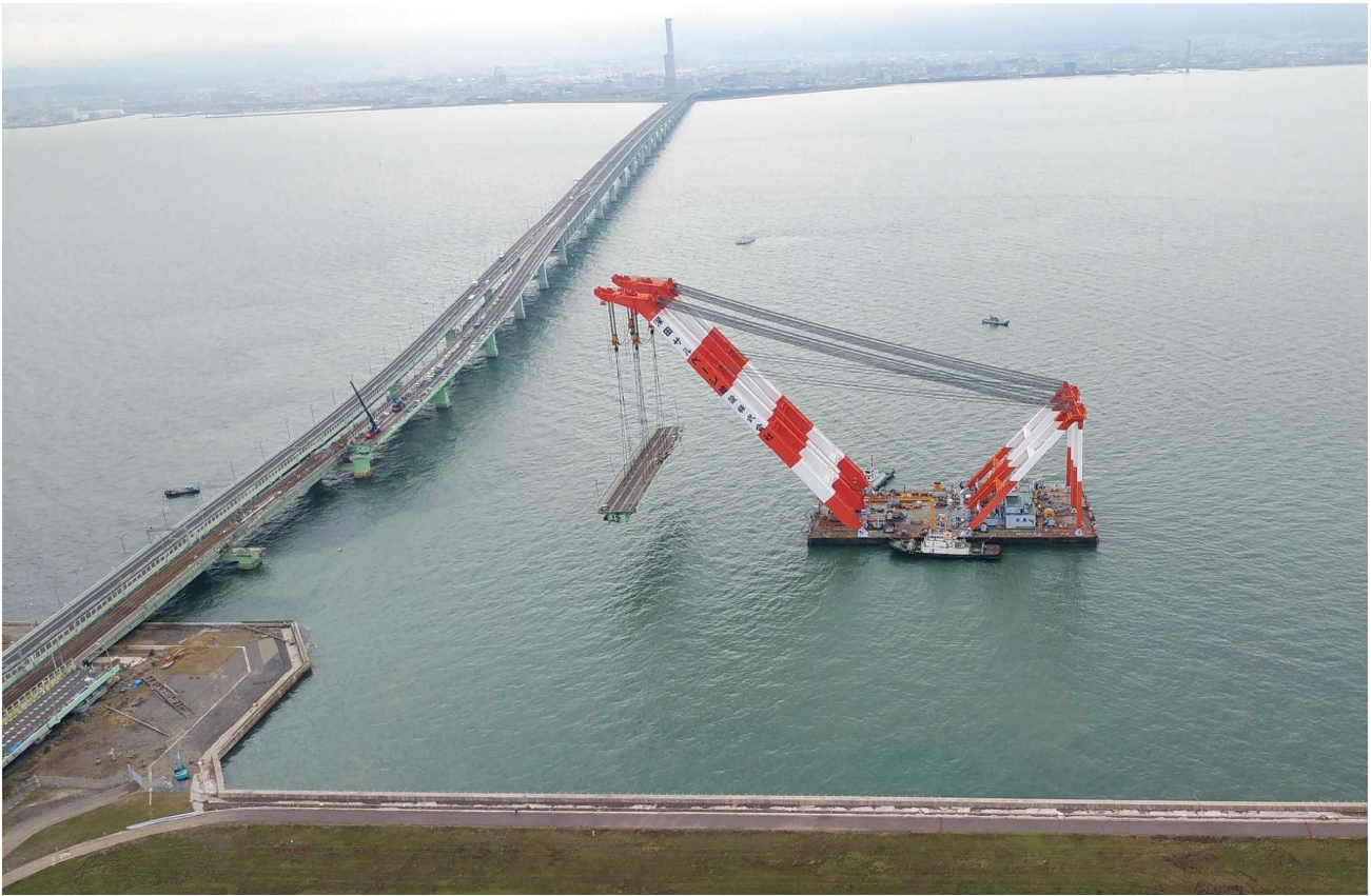
撤去桁吊り上げ状況
