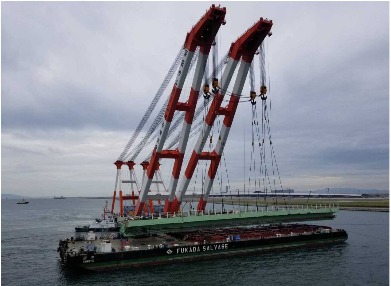
撤去桁台船積込状況
