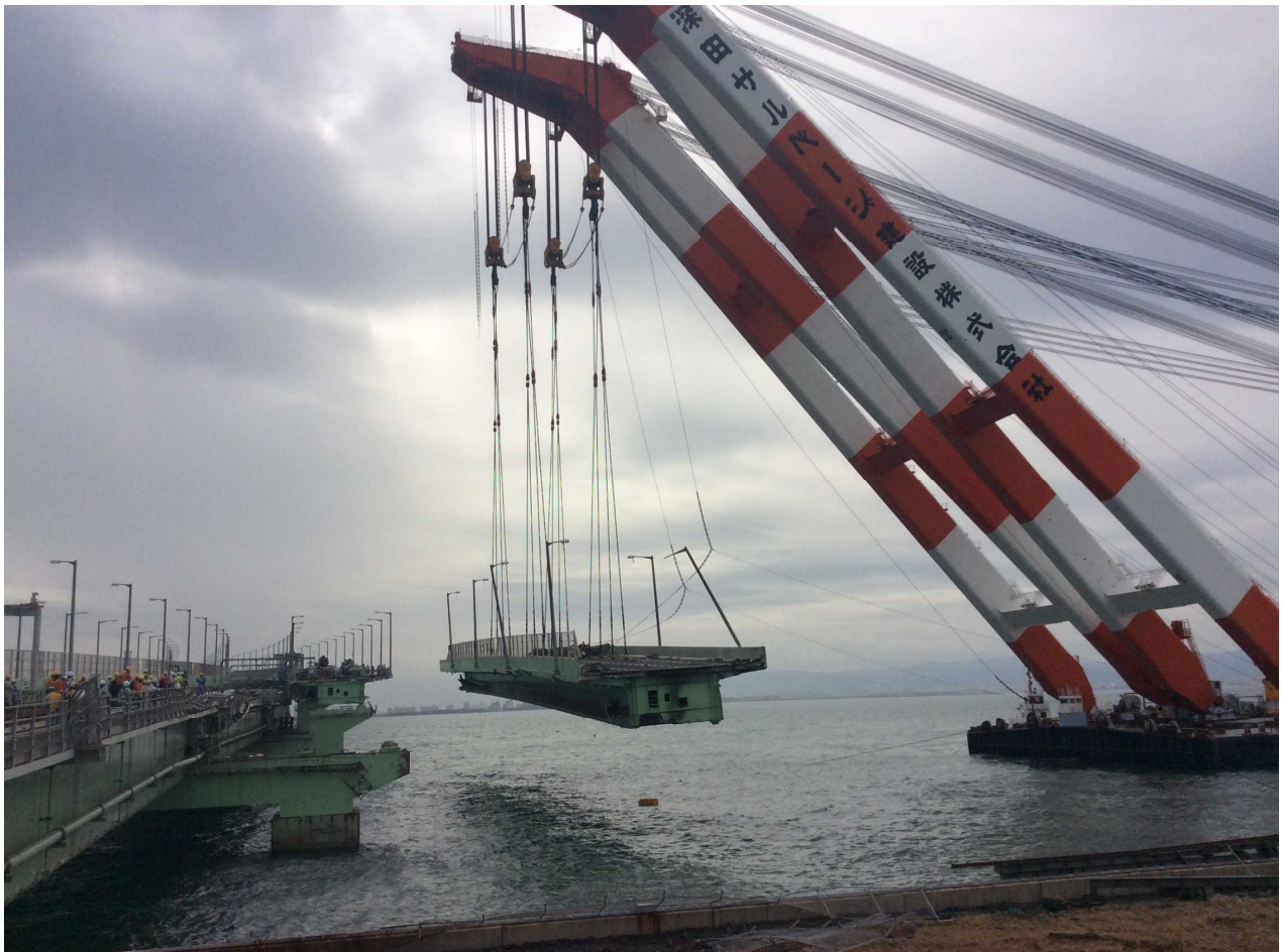
撤去桁吊り上げ状況
