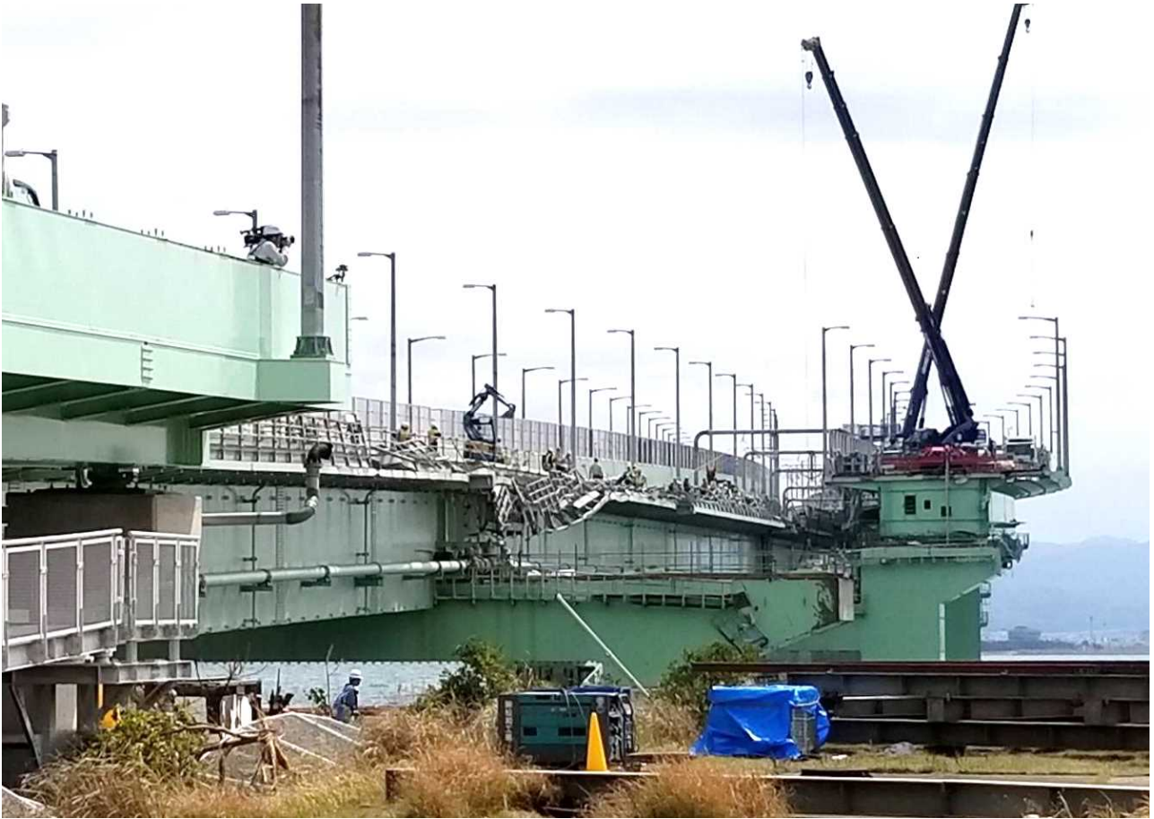
撤去状況(近景)
