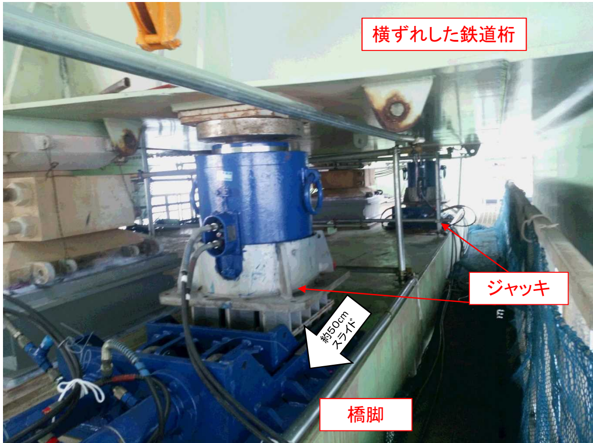
約50cm横ずれした鉄道桁をジャッキにより持ち上げ移動
