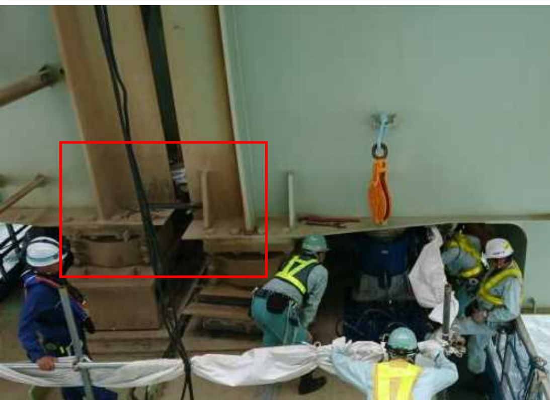
ジャッキアップ前 (9月14日 16時頃)
