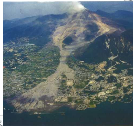
水無川流域の被災状況 (平成5年9月)
