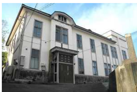
▲再生された歴史的建造物
