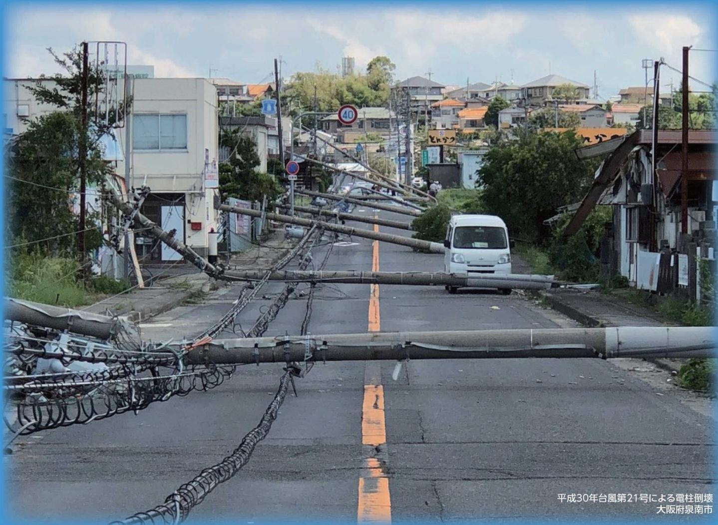
平成30年台風第21号による電柱倒壊
