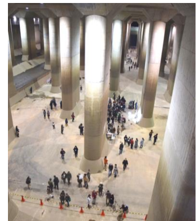
首都圏外郭放水路（埼玉県）
