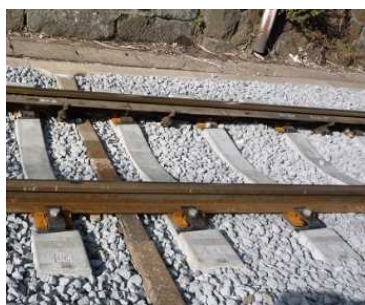
線路設備 (軌道改良(PCまくら木化))
