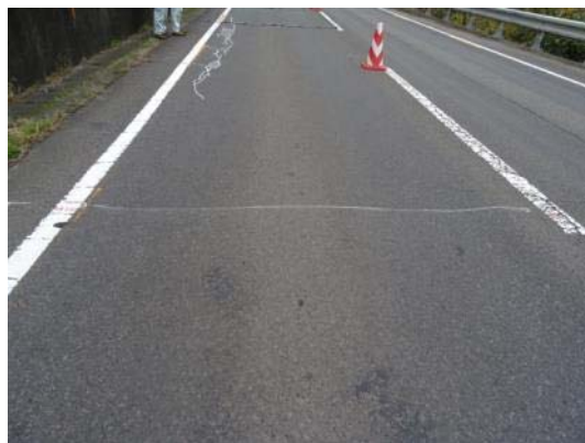
測線マーキング
