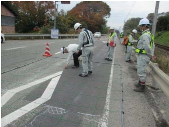
ひび割れ確認
