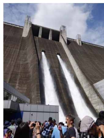
宮ヶ瀬ダム（神奈川県）
