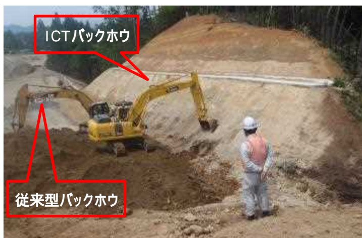
ICTと従来型の建機による施工
