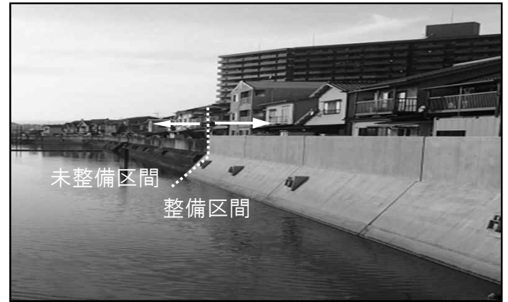
背後の市街地を守る護岸の嵩上げ状況：広島港海岸
