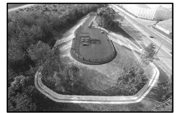
盛土による津波避難施設：宮崎港
