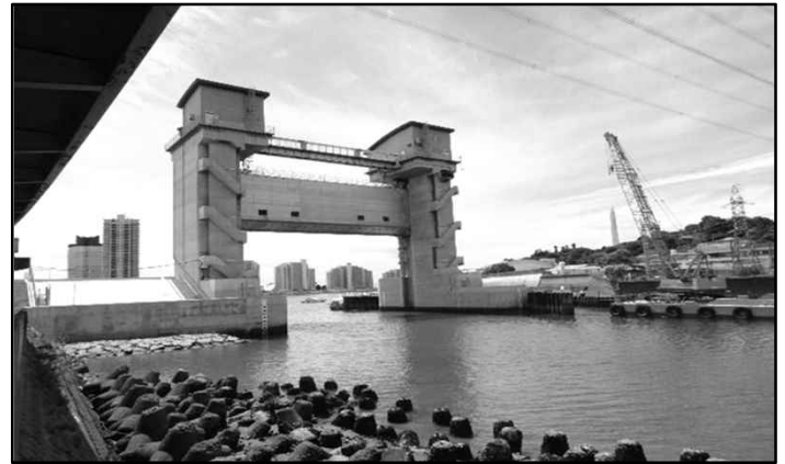
市街地への浸水を防護する水門：和歌山下津港海岸
