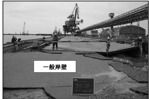
東日本大震災における耐震強化岸壁と一般岸壁の被災状況（小名浜港の例）
