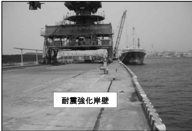
東日本大震災における耐震強化岸壁と一般岸壁の被災状況（小名浜港の例）
