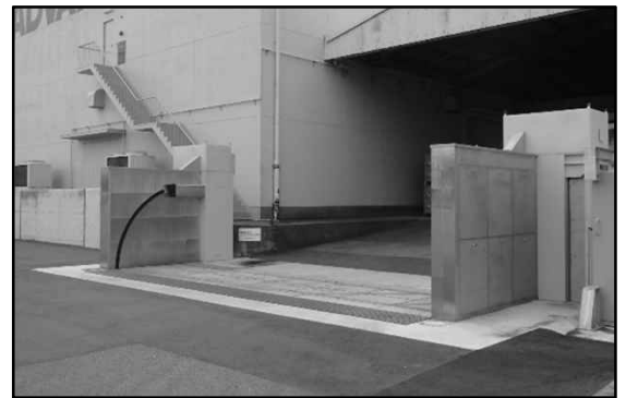
「津波による浮力で閉鎖」するフラップゲート式の陸閘の事例：撫養港海岸
