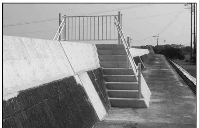
陸閘の廃止：中津港海岸
