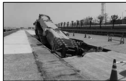
護岸背後の裏埋土の流出による臨港道路の陥没
