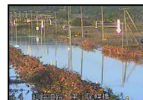
厚岸町内の国道44号冠水状況(写真2)
