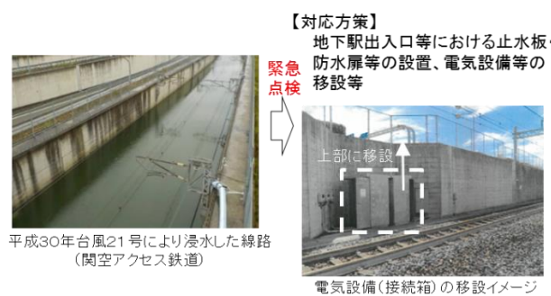
図 3-1 「重要インフラの緊急点検」の概要(鉄道分野)
