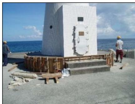
▲鉄筋コンクリートを用い建物の耐波浪強度の低下を予防する。
