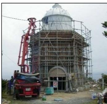
▲鉄筋コンクリート等を用い建物の耐震性能を確保する。
