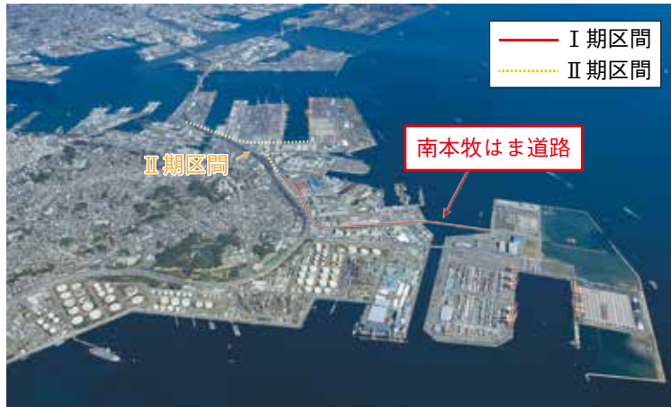
図表2-4-4 南本牧～本牧ふ頭地区臨港道路
