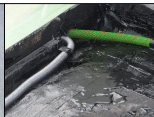
導水管設置例
