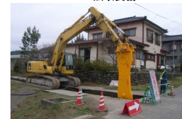
近接施工事例
