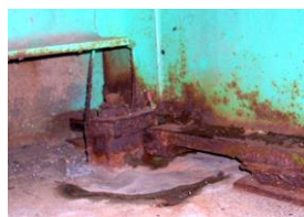
支承交換前(線支承)
