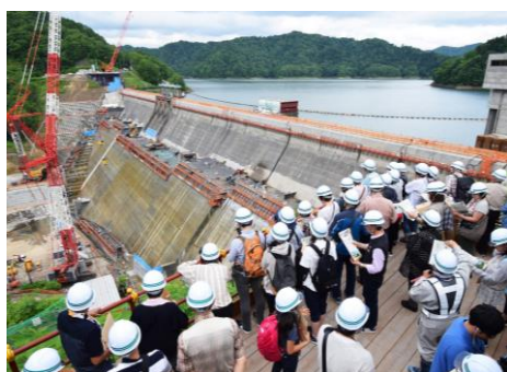
新桂沢ダム 高上工事現場の様子（北海道）
