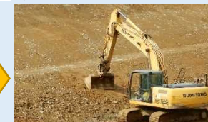
法面整形（ICT建機）
