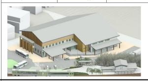
宮城県大崎市による、行政機能に公民館を併せ持つ複合施設を建設するプロジェクト。2層通しのCLTパネルによる外壁面と集成材による軸組構法を組み合わせつつ、口準耐として内部架構の簡易化や現しでの利用を可能とした木造建築である。
