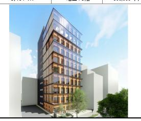
10階建て自社研修施設を木造軸組構法と免震構造により建設する計画であり、これまでの木造建築の階数を大きく上回る規模のプロジェクト。建設地は神奈川県横浜市であり、都市部における中高層耐火純木造建築のモデルになることが期待される。
