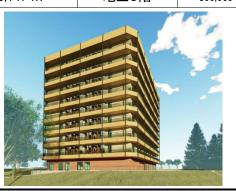
9階建て学生寮を木造軸組構法と免震構造により建設する計画であり、これまでの木造建築の階数を大きく上回る規模のプロジェクト。
