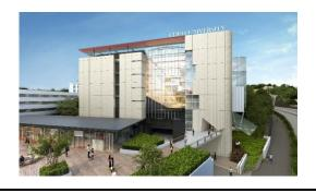
大学構内に6階建ての学部共通棟を新築するプロジェクトで、鉄骨造に円形断面や角型の耐火集成材やCLTを使用した、混構造の計画である。
